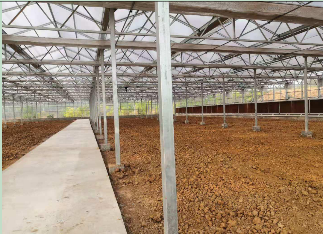
现场图片-2#大棚内部
