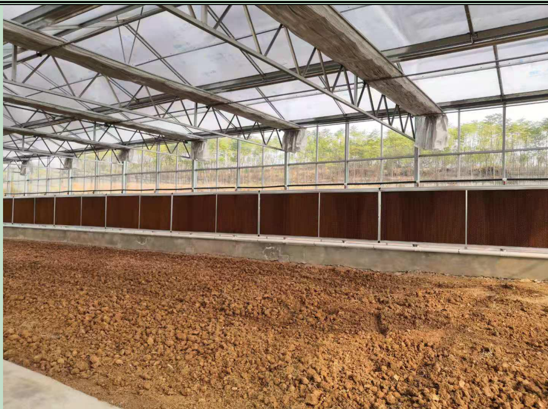
现场图片-1#大棚内部
